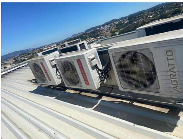
Figura 3 - Condensadoras instaladas no telhado da edificação
