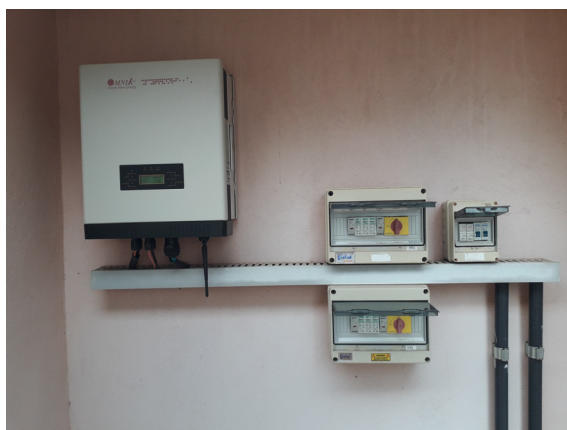
Figura 2 - Inversor no lado direito e os quadros elétricos CC e CA no lado esquerdo da imagem
