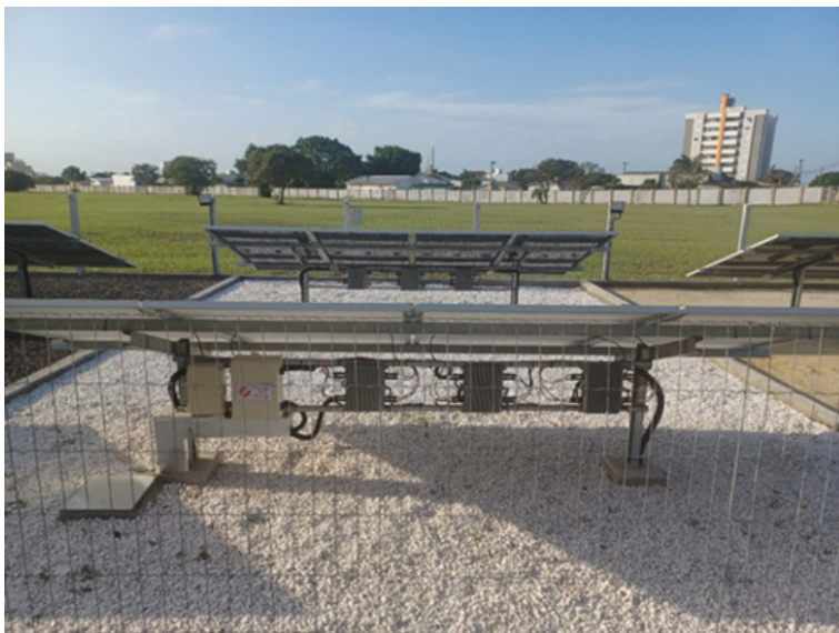
Figura 2 - Instalação dos micro inversores
