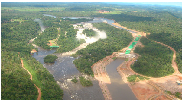
Figura 6 - Usina Hidrelétrica de Dardanelos, do tipo "fio d'água", na cidade de Aripuanã-MT
