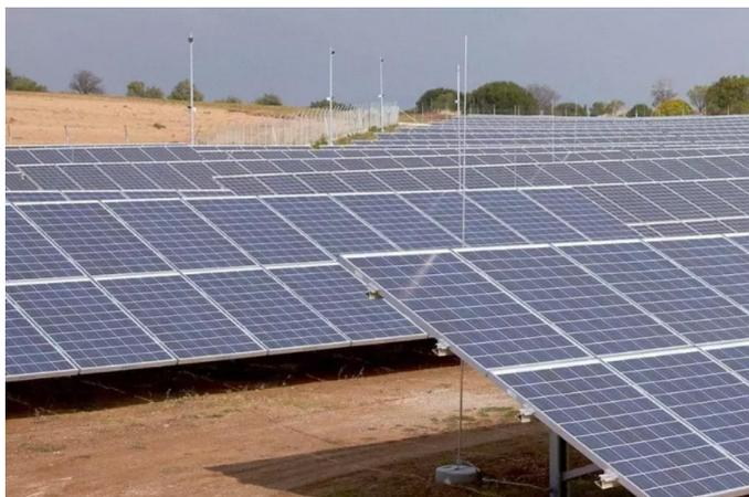
Figura 4 – Instalações reais de um SPDA em um sistema fotovoltaico<sup>1</sup>
