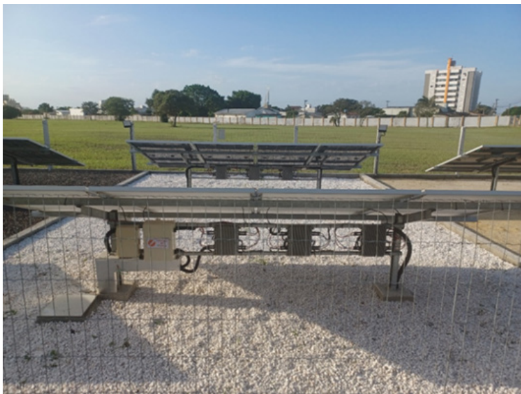
Figura 2 - Instalação dos micro inversores
