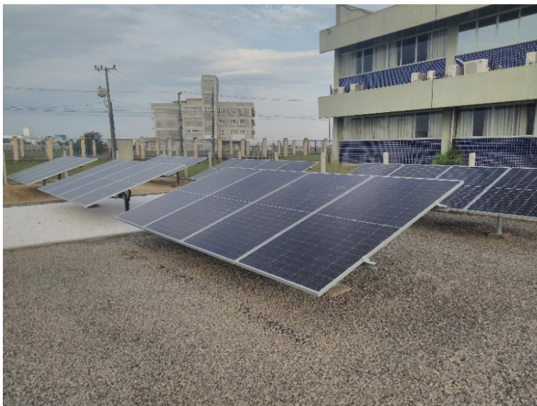
Figura 1 - Planta solar, com módulo bifacial a frente e monofacial atrás
