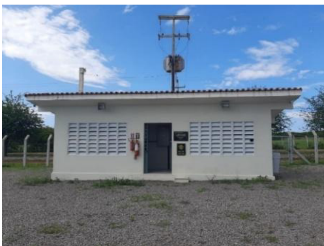
Figura 6 – Abrigo dos inversores da minigeração fotovoltaica da UFRS – Campus Mossoró
