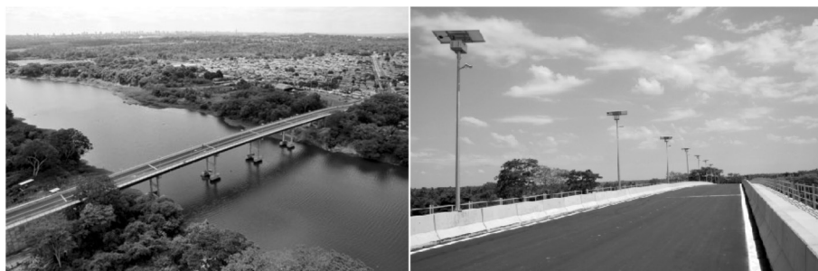
Figura 6 – Imagens da Ponte Leonel Brizola, Teresina – Piauí. (CCom Piauí, 2011)
