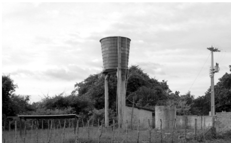
Figura 2 – Sistema fotovoltaico de bombeamento de água, localidade Brejinho - Alto Longá, Piauí. (Foto: Albemerc M. Moraes, fev. 2009)
