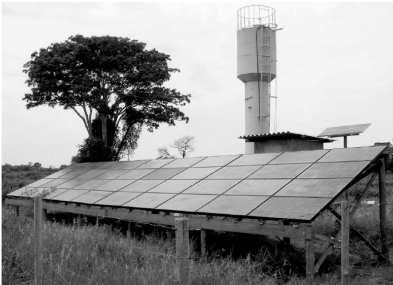
Figura 1 - Instalação fotovoltaica do sistema de bombeamento fotovoltaico proposto
