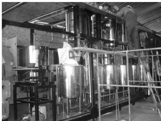
Figura 2 - Construção da estrutura da micro-usina de biodiesel no interior de um contêiner para Projeto da Faculdade do Gama-FGA/UnB.
