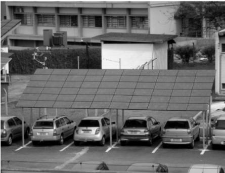
Figura 2: SFCR de 3,0 kW<sub>p</sub> no estacionamento do IEE/USP.
