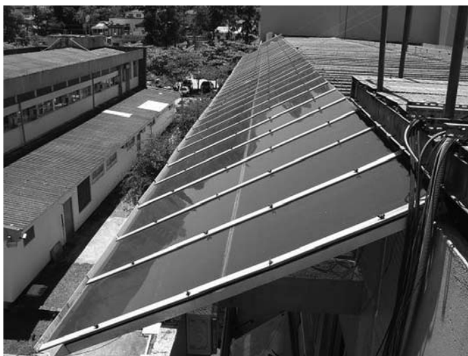
Figura 2: Sistema de 2kWp instalado na UFSC (Fotografado em dezembro de 2005).
