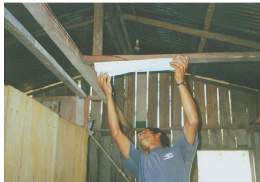
Figura 9. Instalação de luminárias.
