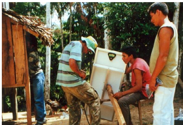
Figura 7. Instalação do gerador fotovoltaico.
